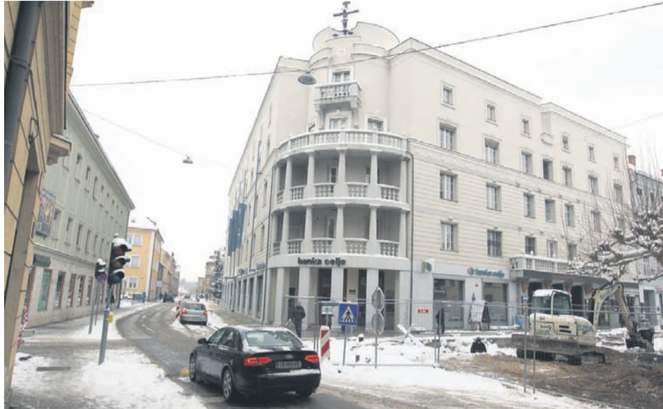
Ena največjih letošnjih naložb v Celju je nadaljevanje obnove starega mestnega jedra. Konec lanskega poletja so začeli najprej obnavljati Glavni trg, zatem pa so gradbišče odprli še na trgu pred Mestnim kinom Metropol in v nadaljevanju Stanetove ulice.
