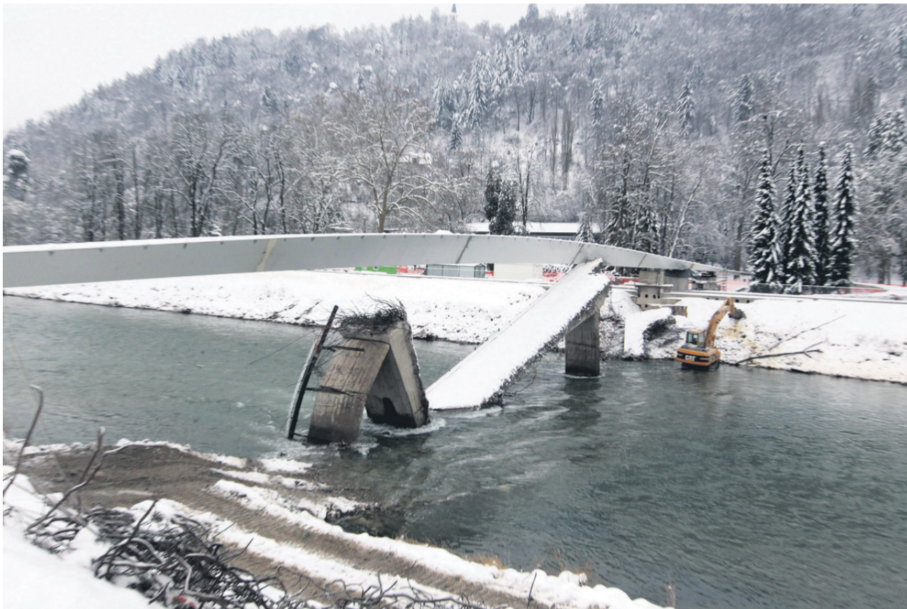
Kljub temu, da je star Splavarski most porušen, pa vseh delov konstrukcije še niso odstranili iz struge. Po načrtih bi morala biti že konec lanskega novembra nova brv v celoti končana, zdaj je rok prestavljen na konec marca.
