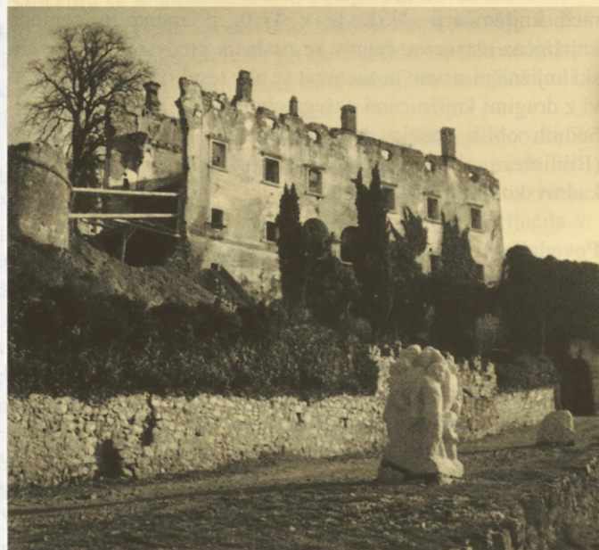
Zahodna porušena fasada gradu Štanjel, 1972
