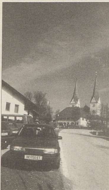
Na Djekšah je število občanov padlo pod 1000. Zato je občina kupila zemljišča za gradnjo novih hiš.
