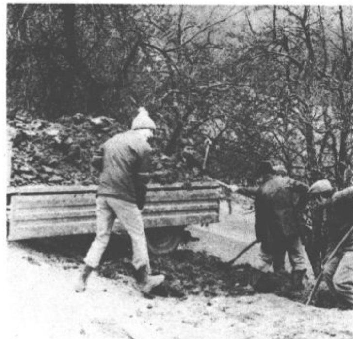
Krajevni Cirkove so lansko jesen asfaltirali cesto od Hrastovca do središča vasi. Mnogo so naredili z udarniškim delom, saj so opravili skoraj tri tisoč udarniških ur. Vendar pa delo še ni končano. Za dni so pričeli z urejanjem bankin. Tudi te bodo naredili s prostovoljnimi delom. Računajo, da bo tudi za to delo potrebno blizu tri tisoč udarniških ur.
