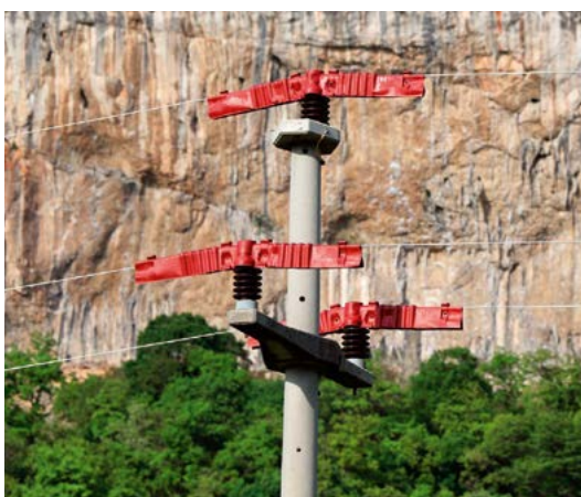
Primer izolacije kritičnih delov sredjenapetostnega daljnovoda na Krasu foto: vse Tomaž Mihelič
