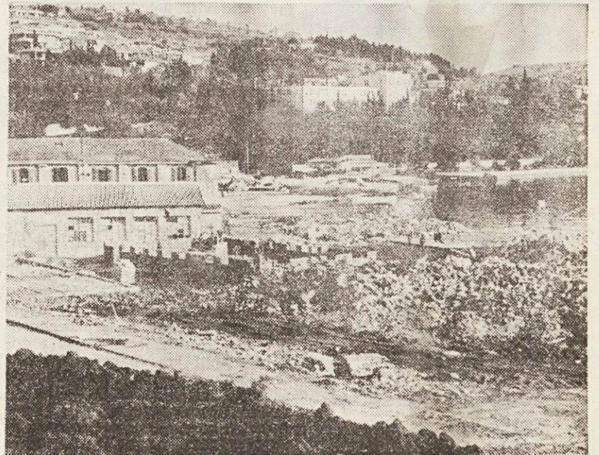
Območje bivše ladjedelnice je postalo eno samo gradbišče
