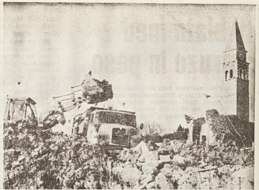
Le stolp cerkve še kljubuje gradbeni mehanizaciji. Zdaj je še ovira, potem bo pa v okras
