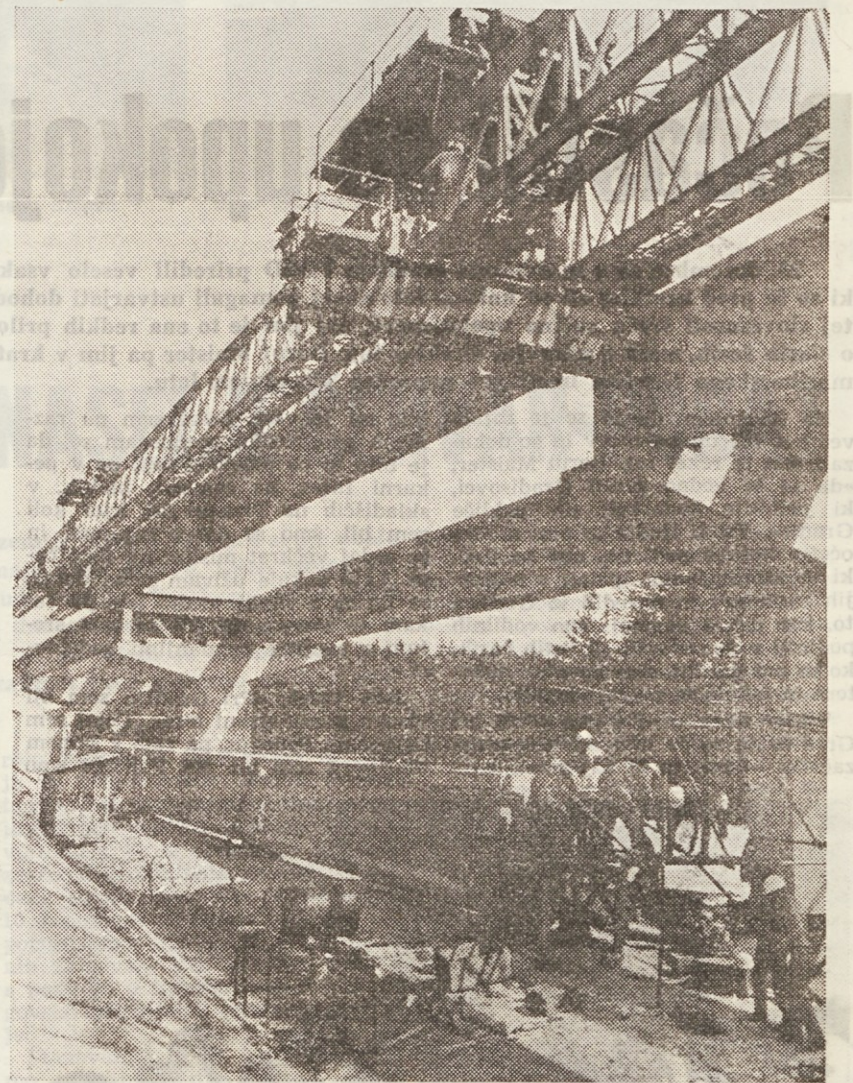
Dvig nosilcev v konstrukcijo za montažo
