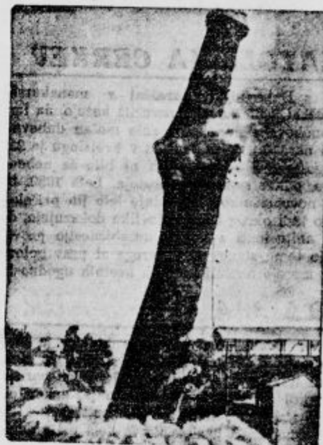
Velik padec orjaškega dimnika, ki je bil zgrajen iz 50.000 kosov opeke v Ameriki, katerega niso podrli z dinamitom, ampak z žično vrvo.
