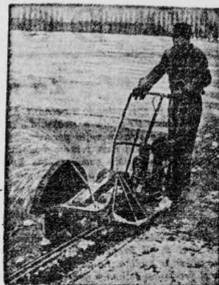
V Nemčiji so iznašli strojno žago za rezanje ledu. Stroj goni mal bencinski motor
