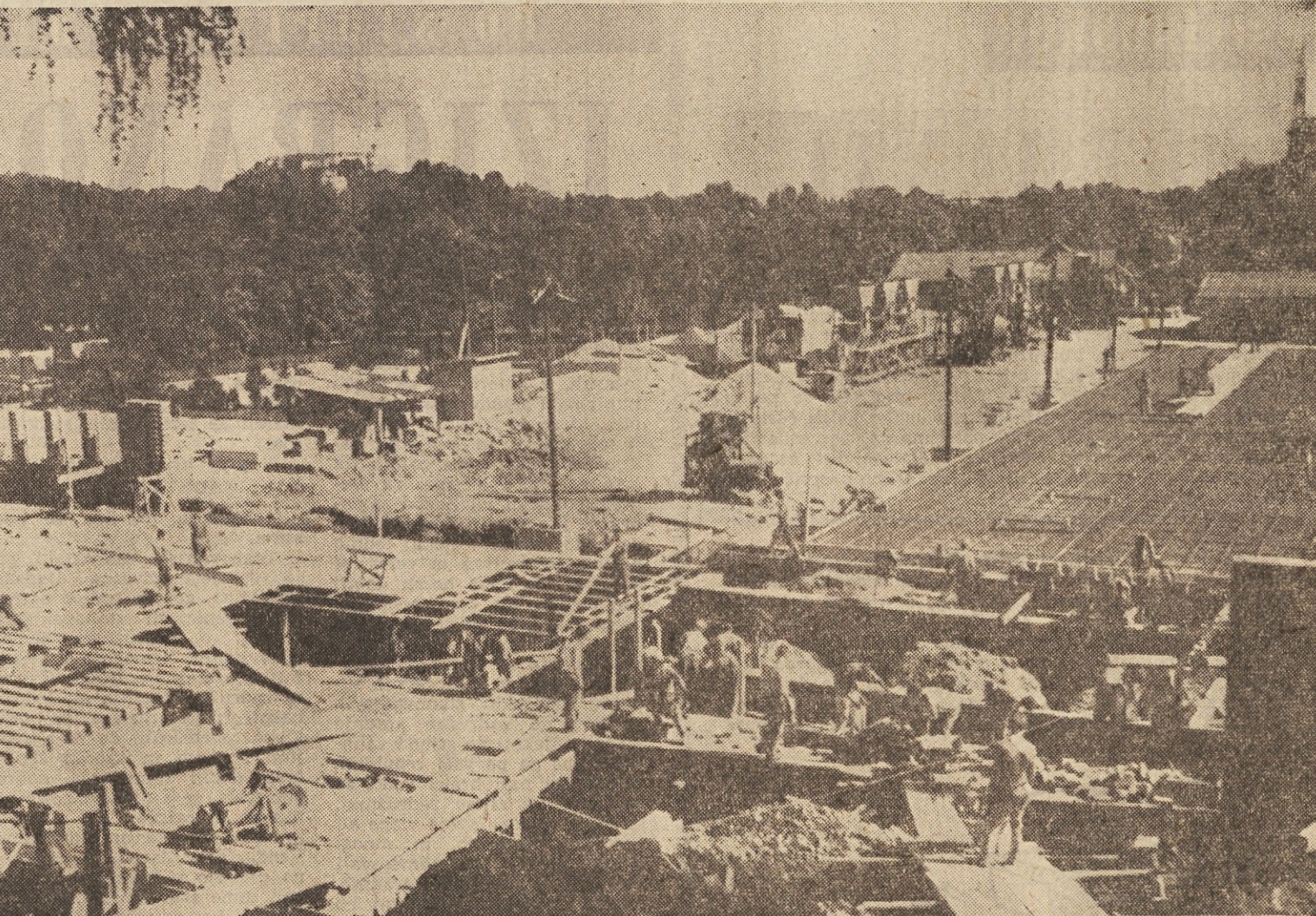
Le še malo pa bo na kotalkališču v tivolskem parku nova betonska plošča. Delavci so pohiteli z betoniranjem, kajti na tem objektu bo na večer pred dnevom vstaje eno izmed mnogih zabavišč
