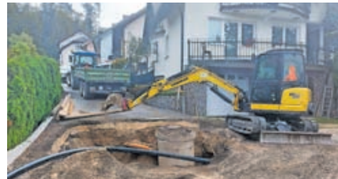
Začela se je sanacija kanalizacijskega sistema na Prisojni poti. / FOTO: OBČINA KAMNIK
