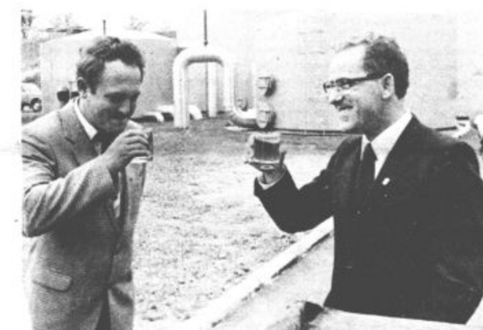
Predsednik velenjskega izvršnega sveta Božo Lednik ter direktor delovne organizacije Vekos Jože Mraz sta sistem otvorila, tako da sta si nazdravila s kozarcem vode iz novega vodovoda
