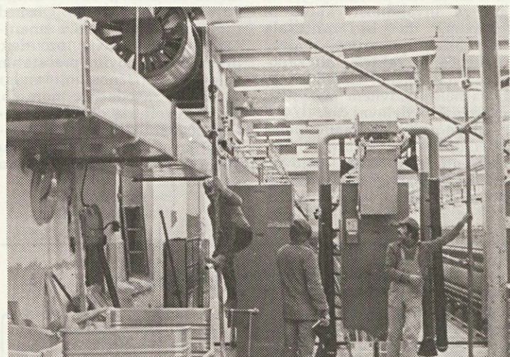
Delavci IMP Ljubljana pri zaključnih delih montiranja klimatskih naprav, s katerimi se bodo izboljšale delovne razmere, predvsem v poletnem obdobju.
