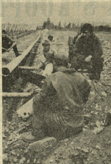
V prvi polovici maja — v re- kordnem času — so naši in ita- lijanski delavci končali polaga- nje cevi namakalnega sistema pod Braslovčami
