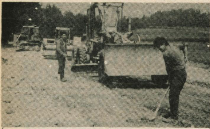
Prihodni teden tudi asfalt — Prihodni teden bo Cestno podjetje Kranj na cesti Kranj-Golnik med Goričami in Tenetišami na enokilometrskem odseku končalo ureditvena dela. Denar za ureditev je zagotovila Skupnost za ceste Slovenije. Cestno podjetje pa je začelo delati v začetku julija.—A. Ž.
