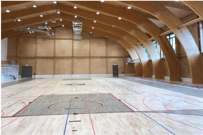
Dvorana pred vgradnjo opreme.
