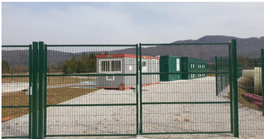
Gradnja osrednje Čistilne naprave Bruhanja vas.
