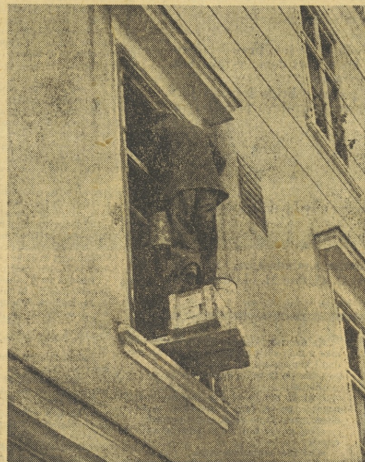
Delavec Mestnega vodovoda iz Ljubljane pri vzidavanju okenskih okvirov — brez komentarja
