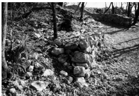
Stranski zaključek obnovljenega podporno-razmejitvenega zidu št. 7.
