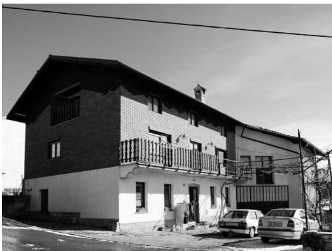
Domačija Šembije 57. V novo »preobleko« odeta domačija z nameščeno tipsko ograjo na gank, streho s štrlečimi napušči in stavbno opremo iz aluminija.
