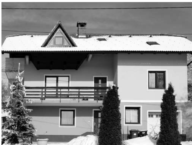
Hiša Mala Brda 13. Izvedba strešnega okna, frčade, z leseno podkonstrukcijo nad balkonom, kar ni tukajšnja značilnost. Foto: Eda Belingar, Mala Brda, 2013
