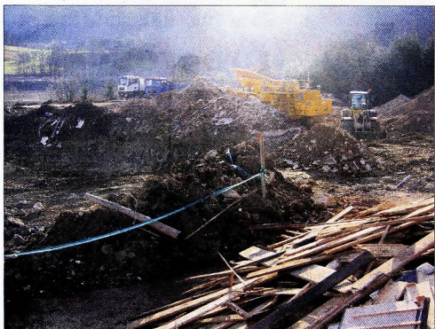
Na gradišču nove šole na Polulah pripravljajo teren za začetek gradbenih del.
