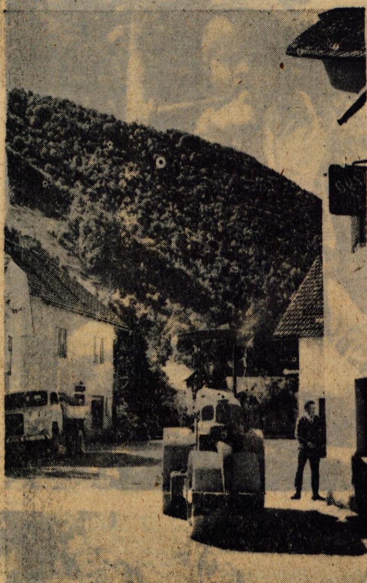
Takole so se v Češnjici v Selski dolini lotili in izvedli rekonstrukcijo cest in urejanja tega kraja
