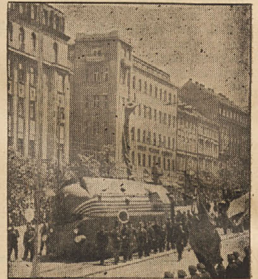
V sprevedu ob priliki 60 letnice soc. dem. v CSR peljejo železničari model najnovejše aerodinamične lokomotive.
