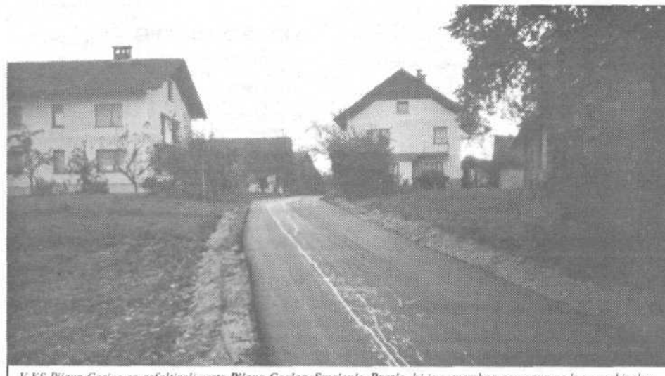
V KS Pijava Gorica so asfaltirali cesto Pijava Gorica-Smrjenje-Brezje, ki je pomembna povezava ne le za prebivalce teh krajev, temveč tudi vasi Vino iz sosednje občine Grosuplje. Brezje: prstovoljnega dela in prispevok 1000 DEM po hiši ne bi slo. Največ je prispeval g. Janez Piskur, okrog 2000 kubičnih m peska iz lastnega kamnoloma, denarni prispevek so dali še Club Royal, SAMM d.o.o., Paurex, 1 trgovina in Gostilna Cot. Za zaključek del potrebujemo še sredstva občine. Vicer te občine Grosuplje. Na sliki: prvi metri asfalta v vasi Brezje
