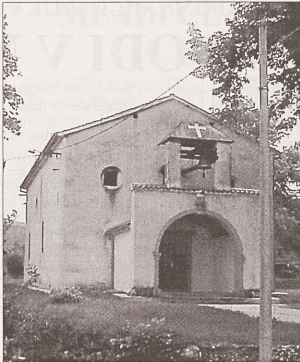
Baročna cerkev sv. Mihaela, zgrajena 1677 in obnovljena 1824 leta. Zanimivo je, da cerkev nima zvonika - turna, ki se ni naredil zaradi nesoglasja med gospodarjem graščine in vaščani.
