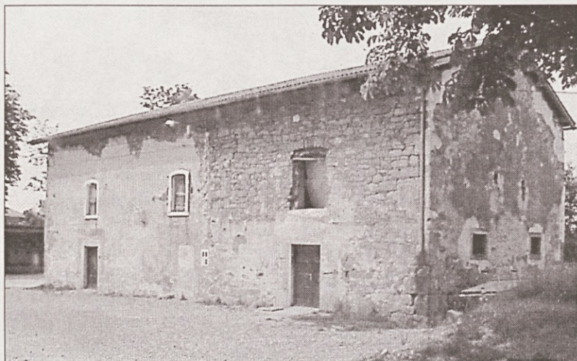
V tej stavbi so prostori Krajevne skupnosti Dolnji Zemon
