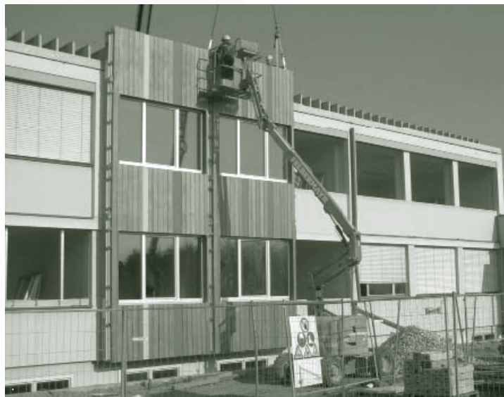
Slika 3: Nameščanje fasade
