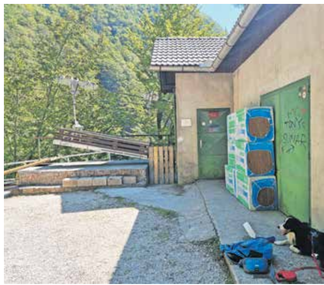
Ves stari in novi gradbeni material so s koč in do njiju prepeljali s tovorno žičnico; na sliki žičnica na Kamniško sedlo. / FOTO: JASNA PALADIN
