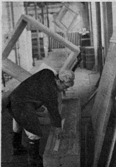
Vezana okna pred dokončno montažo pobarvajo.
