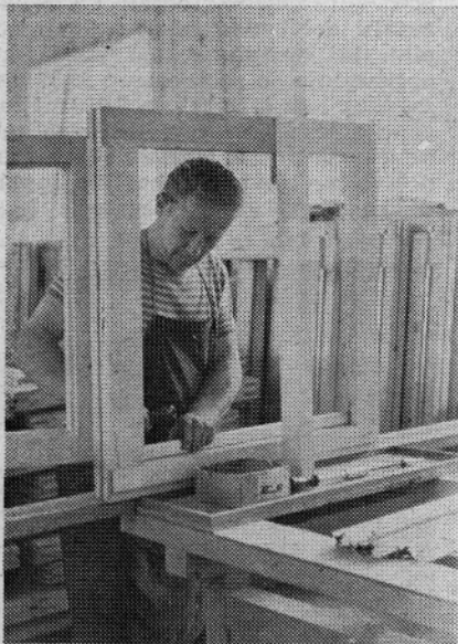
Montaža aluminijastih okapnic in letev za zasteklitev.
