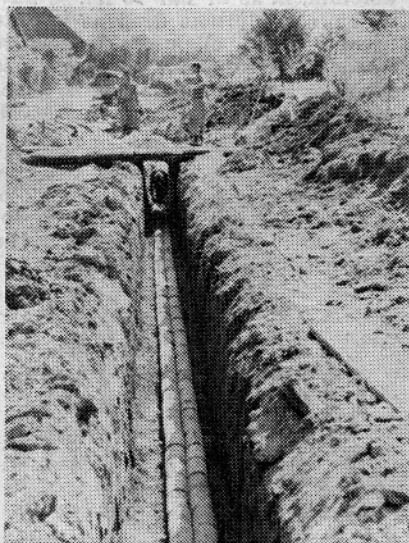
Polaganje cevne drenaže
