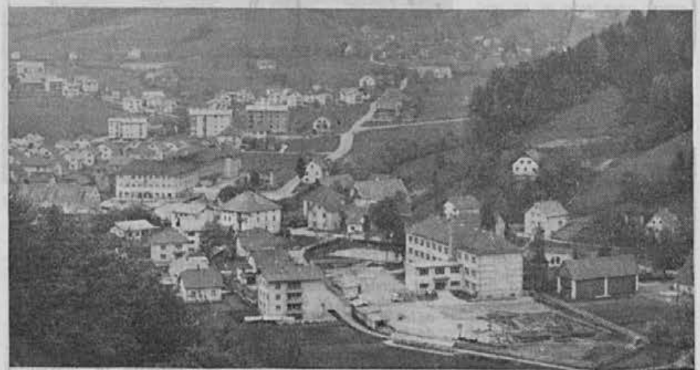
Pogled na gradbišče telovadnice in vrtca
