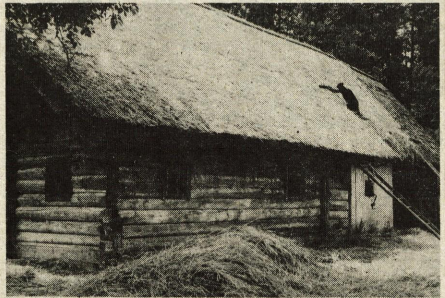
SKOFJA LOKA - Škoparjeva hiša na loškem gradu je dobila novo slamnato streho iz najboljše, ržene slame. Stala bo kot zanimivost, ki jo je najti le redkokje... Foto: F. Perdan
