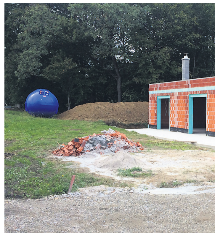
Zorčevi računajo, da bi jih gradnja sekundarnega komunalnega cevovoda do na javni vodovodni sistem ni mogoča.
