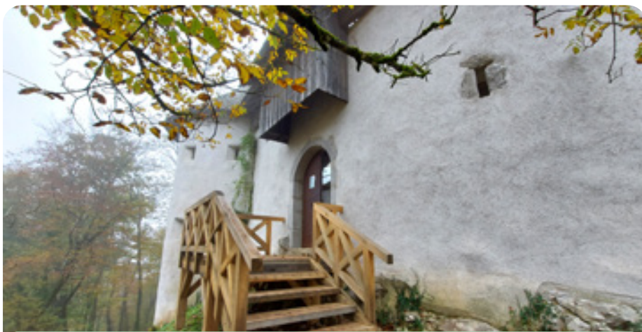
Novo vhodno leseno stopnišče s podestom.
