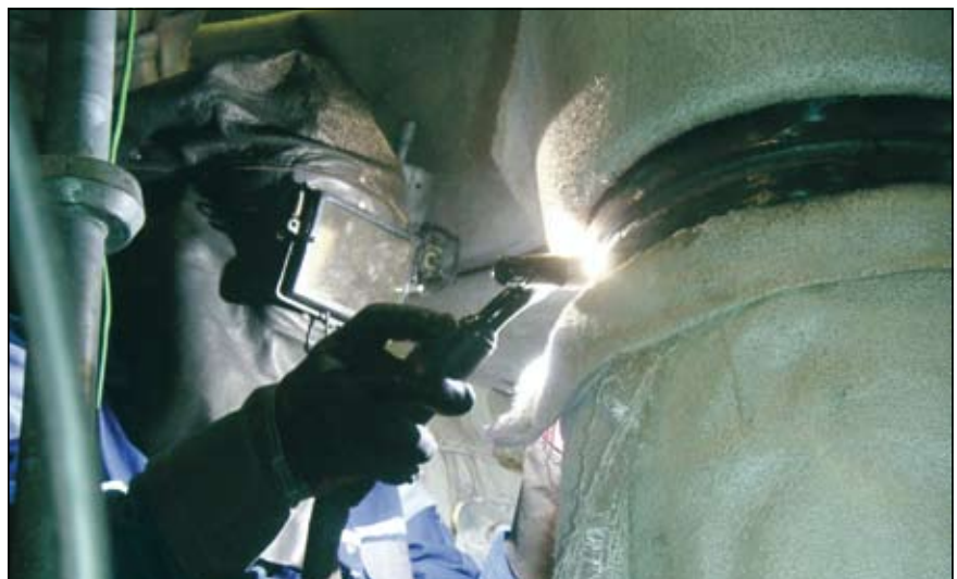
Varjenje priključka pri zamenjavi izločevalnikov vlage iz pare – NE Krško
