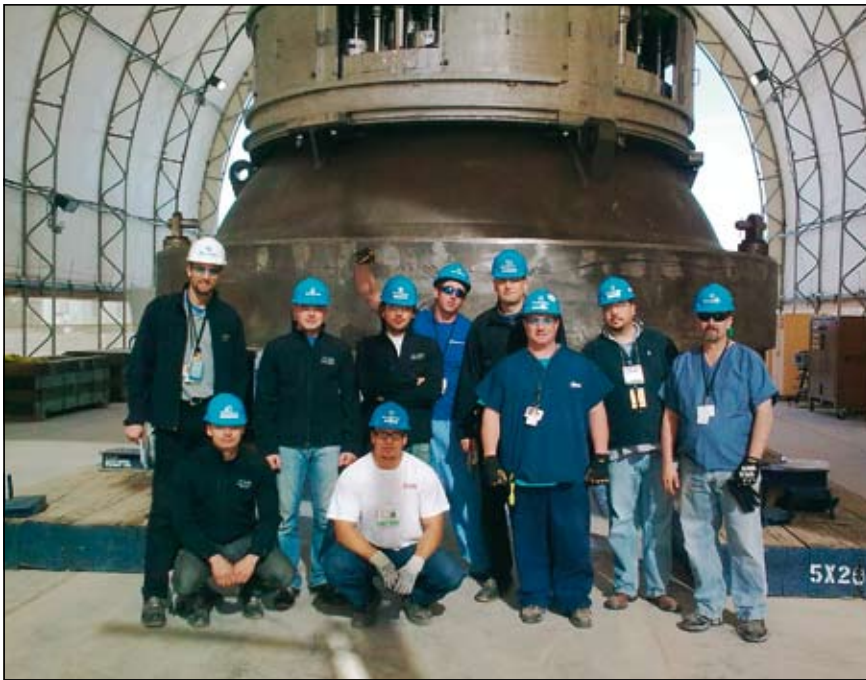
Zamenjava glave nuklearnega reaktorja, ekipa Westinghouse – Numip pred novo glavo reaktorja, Nuclear PP, Palo Verde, ARIZONA
