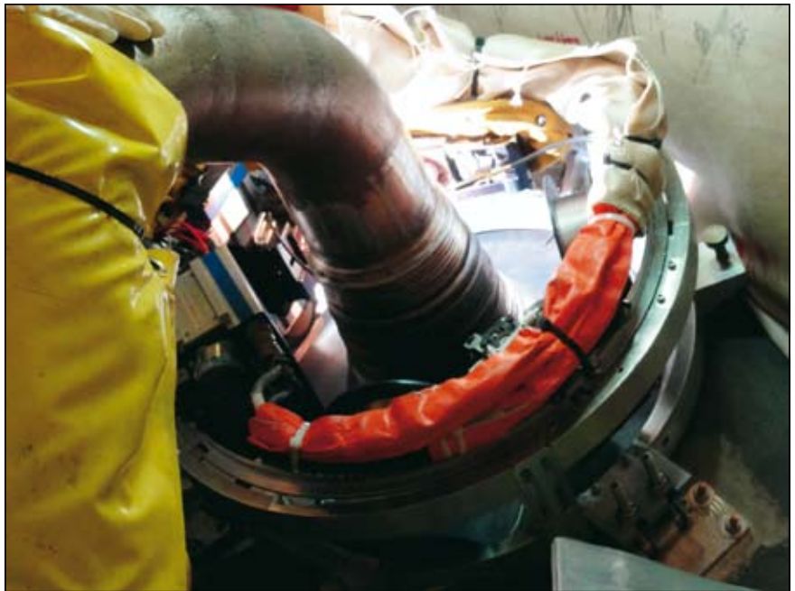
Konstruktivsko navarjanje tlačnika ( AREVA – NUMIP ) – NE Krško
