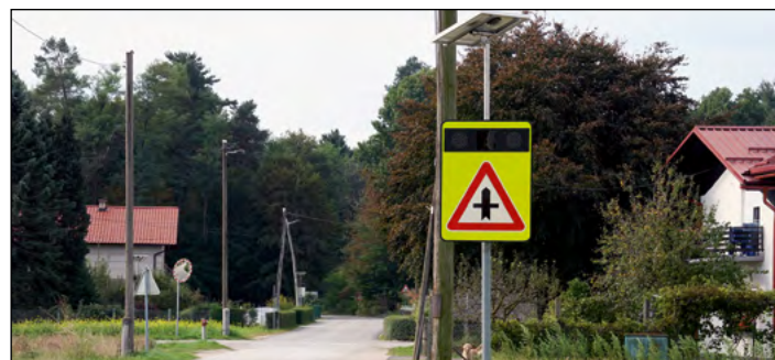
Novo v Gerečji vasi – opozorilni sistem COPS@road. Sistem s svetlobnim signalom voznike opozarja na potrebo po večji previdnosti pri vključevanju s stranske ceste v času, ko se po glavni cesti približuje drugo vozilo. Občina Hajdina želi s tem dejanjem prispevati k izboljšanju varnosti prometnih udeležencev na tem nevarnem križišču.
