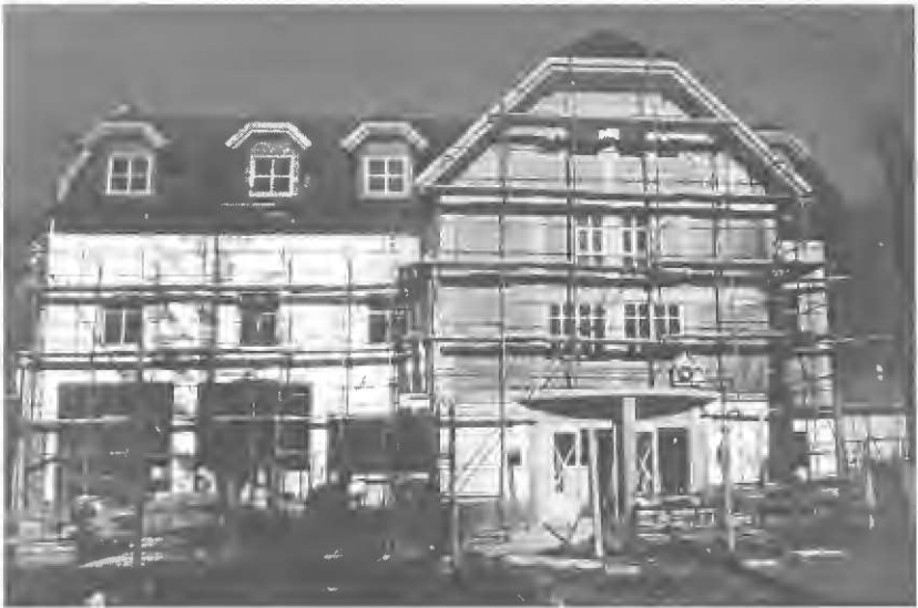
Gasilski dom v gradnji (1998)
