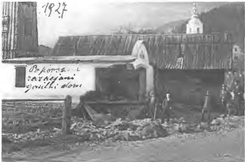
Po poplavi v letu 1927 je bil dom zelo poškodovan
