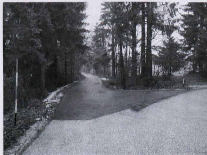
Asfaltacija K v Vrcela. Foto: Tomaž Mivšek
