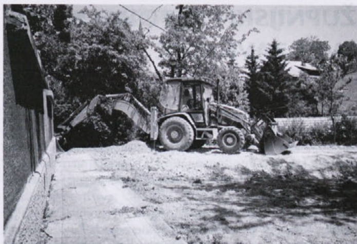
Zemeljska dela pred šolo. Foto: Sašo Pintar
