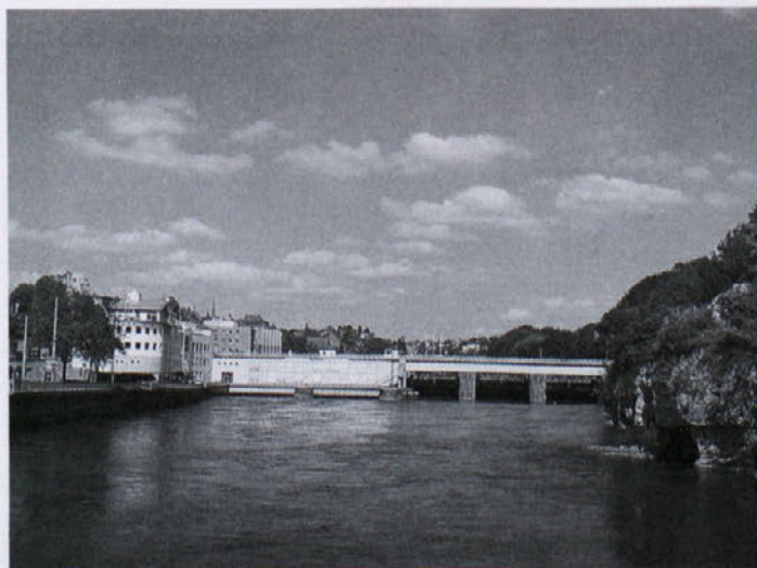
Elektrarna na Renu poleg mesta. Foto: Andrej Mlvšek
