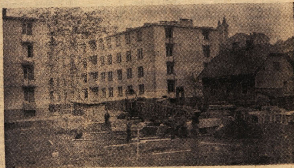
Ob Cesti zmage pripravlja Gradbeno podjetje Zagorje gradbišče za nov 20-stanovanjski blok, ki bo imel pet etaž
