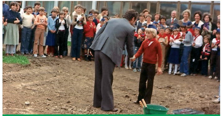
Gradnja nove šole. Vir: Šolska kronika
