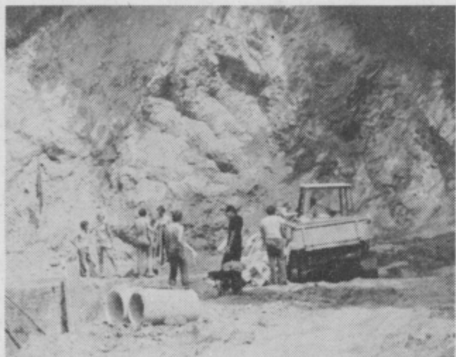
Brigadirji pri zaključnih delih zelo zahtevnega odseka nove ceste v vasi Paneče pri Jurkloštru
