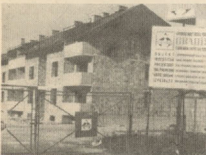
Gradnja stanovanjskega bloka pri velenjskem parku se bo nadaljevala, ko bo RLV zanjo imel denar.
