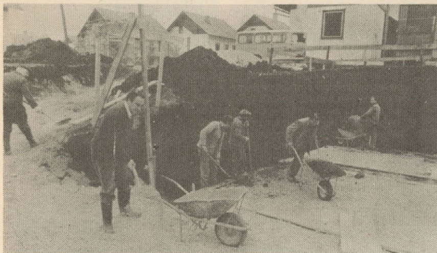
V torek, 13. novembra, so delavci RLV za novo hišo Rakunovih opravljali končna dela pri izkopu temeljev. (slika Lojze Ojsteršek)
