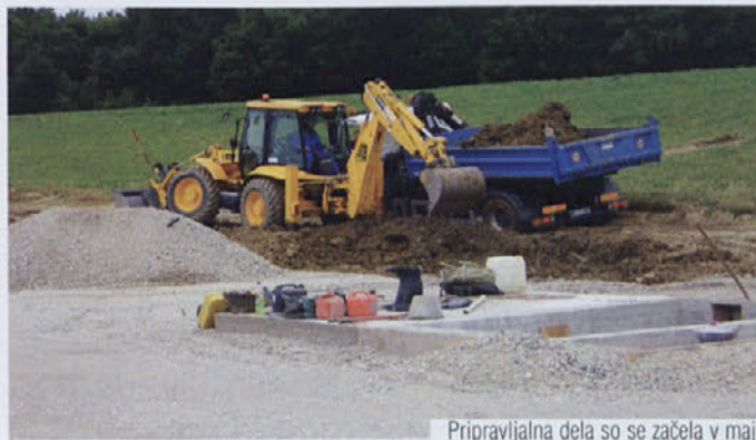
Pripravljala dela so se začela v maju
