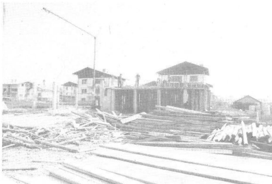
Gasilni dom Kozarje
