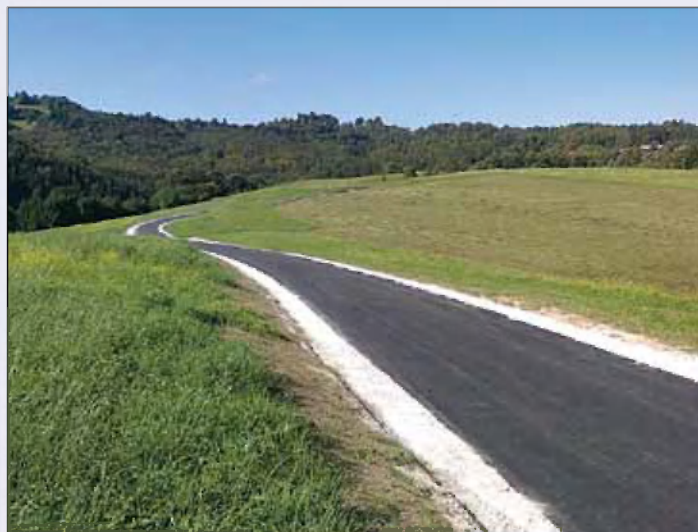
Odsek Javorje – Škamevec
