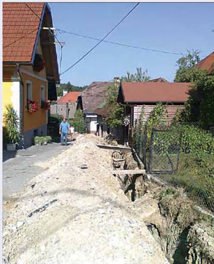
Gradnja vodovoda – Zazid
