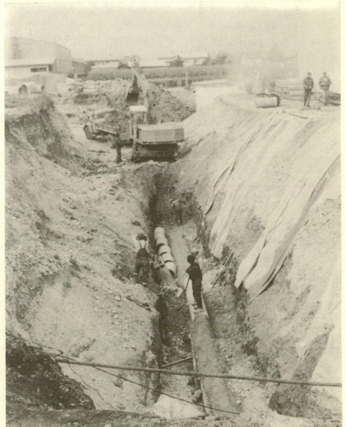
Šest metrov globok izkop za kanalizacijo
