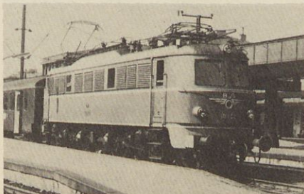
Lokomotive serije 1018 za hitre vlake so izdelovali v Avstriji po nemški licenci v letih tik pred drugo svetovno vojno.
