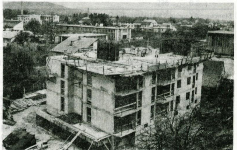
Stanovanjska soseska ob ulici Ljube Šercerja v Domžalah, ki jo gradi GP „Obnova“ Ljubljana s tremi 12 nadstropnimi stolpnici. Predvidenih je 210 stanovanj.
