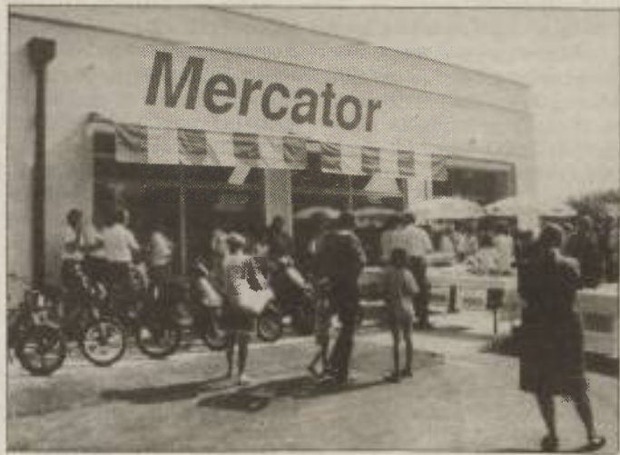
Nekoč zanemarjena hala Platane, danes sodoben poslovni center. Fotografija: Jure ZAUNEKER
