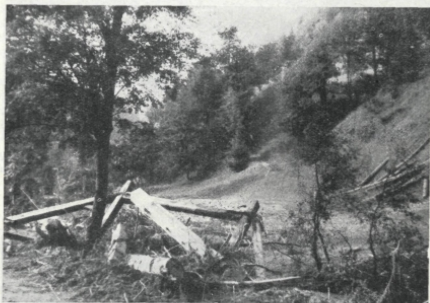
Sl. 34. Ob močnejšem deblu se je zaustavil most, ki ga je transportirala Velunja več sto metrov daleč
