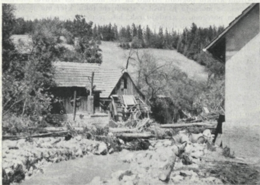
Sl. 16. Zaradi številnih debel in obilice drugega materiala, ki ga je nosil Sumec ob katastrofi s seboj, je prišlo pri hiši št. 4 v Podkraju do prve večje zaježitve
