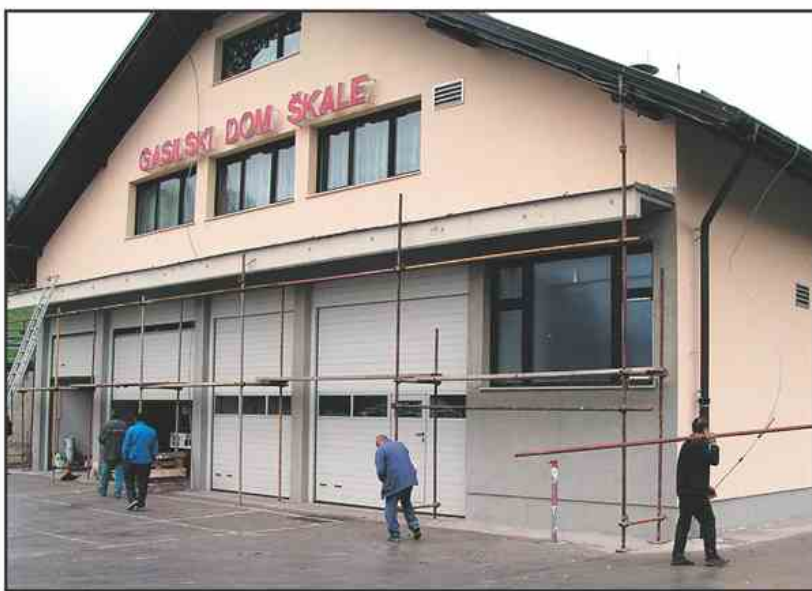
Dela pri obnovi zunanosti gasilskega doma v Škalah hitro napredujejo. (Foto: S. G.)
