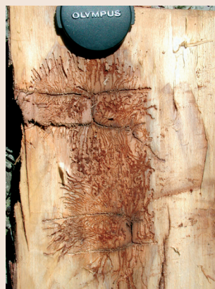
Slika 19. Rovni sistem krivozobega jelovega lubadarja ( Pityokteines curvidens ) je viden predvsem v ličju skorje jelke, če je skorja tanka (foto: M. Jurc)
