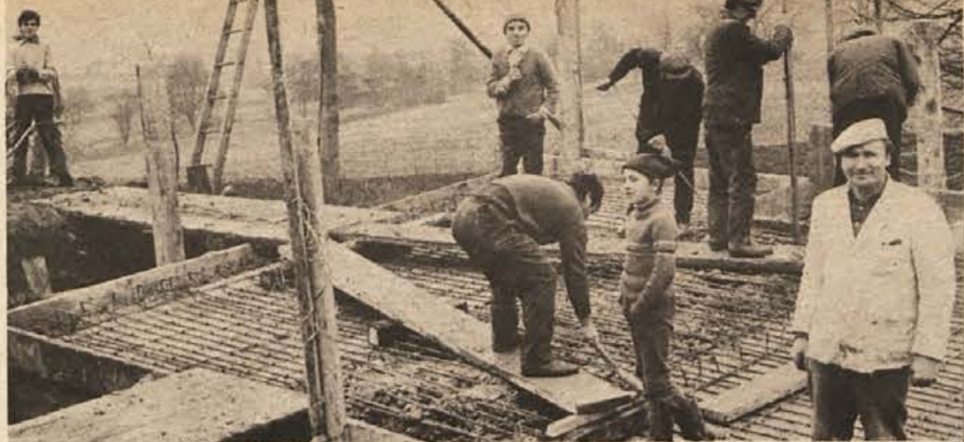
60 kubičnih metrov bo držal vodni zbiralnik, ki ga gradijo v Gornjih Kamencih. V nedeljo, 8. decembra, so po volitvah zbiralnik betonirali (na sliki). Prostovoljnega dela se je udeležilo 25 ljudi, med njimi tudi muzikant Henček Burkat, ki je pomagal pri dovozu materiala s traktorjem. (Foto: I. Zoran)
