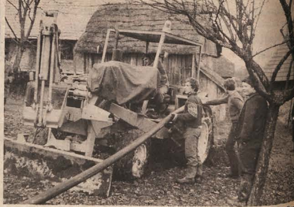
S strojem gre hitreje. Posnetek je iz vasi Kalce - Naklo, kjer si vaščani napeljujejo vodovod. Tudi so zavzeto pomagajo s prostovoljnim delom. (Foto: Jožica Teppey)
