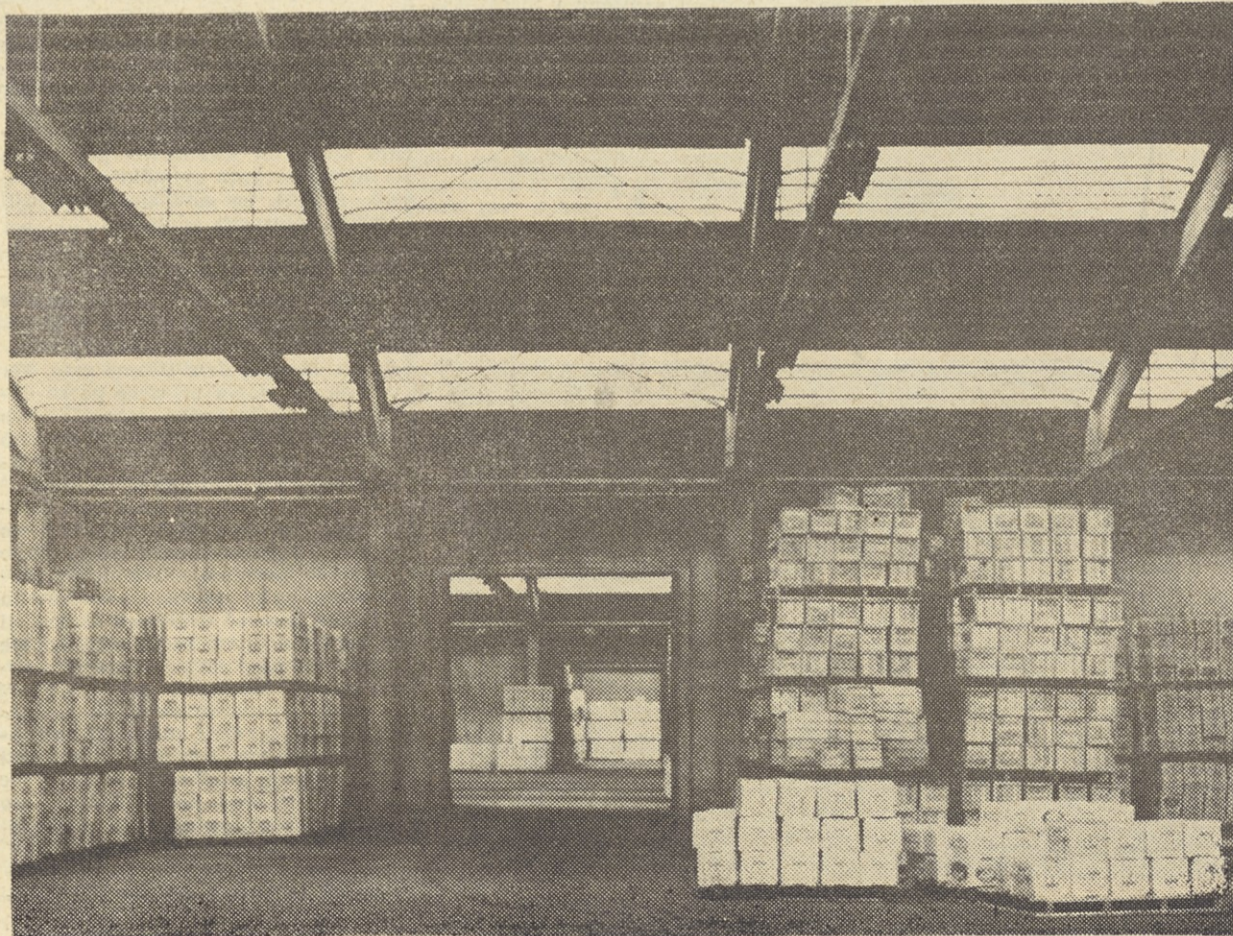
Pogled v notranjost skladišča velike hale v Kopru. V skladiščih se v glavnem nahaja južno sadje.
