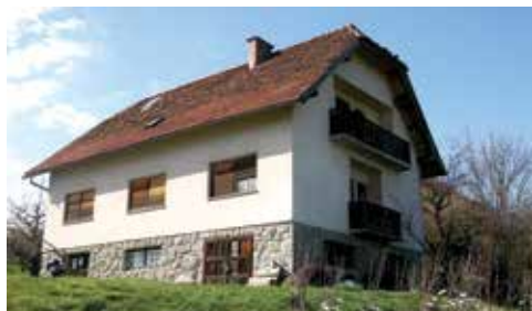
Novi dom Klemšetrovih, Šentilj, zgrajen leta 1964.
