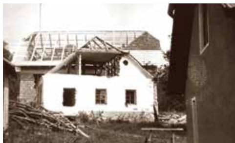
Rušenje stare hiše Klemšetrovih, v ozadju nova gradnja, Šentilj, leta 1964.
