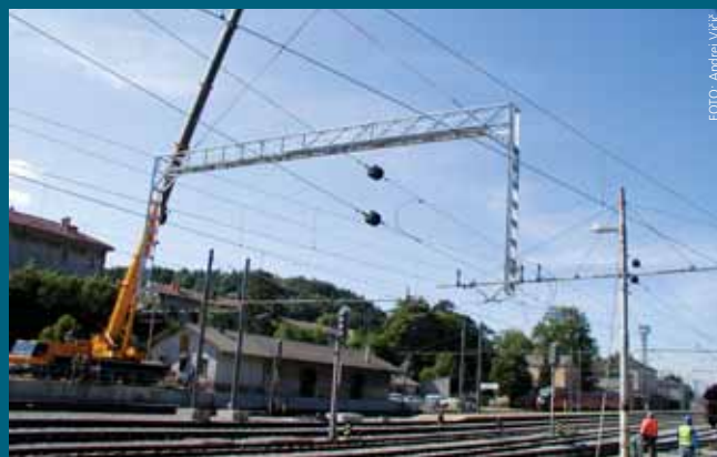
Postavljanje jeklene mostne konstrukcije z avtodvigalom, 21. junija.
